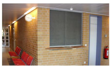
Durchreichen, Empfangsbereiche oder Pausenverkäufe sind Anlaufstellen, welche häufig im notwendigen Flur positioniert sind. Der tägliche Komfort mit der Gewissheit über die Schottung im Brandfall wird mit Feuerschutzvorhängen gewährleistet.
