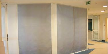
Atrien liefern aus architektonischer Sicht hervorragende Gestaltungsmöglichkeiten, die oft und gerne genutzt werden. Brandschutztechnisch gesehen ist eine Abtrennung der offenen Geschosse meist unumgänglich. Rauchschutzvorhänge liefern im vorliegenden Fall eine perfekte Lösung. Im täglichen Betrieb beeinträchtigen sie die Optik des offen gestalteten Atriums nicht, im Ernstfall schotten sie die Retungswege ab und schaffen maximale Sicherheit vor Rauch und gegebenenfalls auch vor Feuer.
