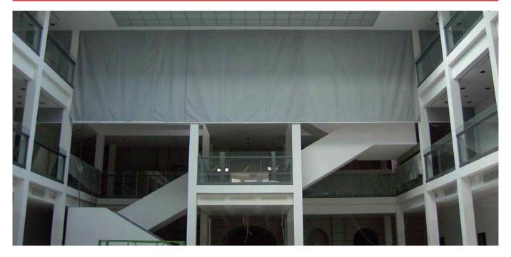
Auch weitläufige Anwendungenfälle sind mit dem Smoke PROtec® System realisierbar. Das Multi-Roller-Konzept erlaubt Anwendungen mit einer Breite von bis zu 30 Meter. Im Einzelfall auch mehr.
